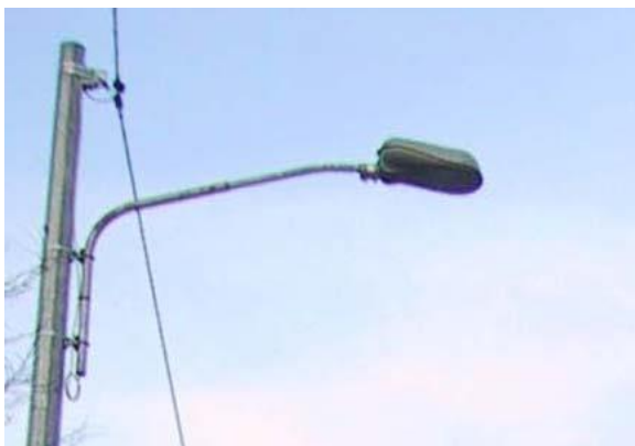
SP 69: armatura stradale con ottica totalmente schermata rispondente alla L.R. 17/2000 e alla L.R. 38/2004
