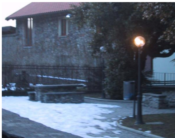
Area pubblica di Brezzo - percezione diurna e notturna: apparecchi decorativi tipo globo diffondente non conformi alla normativa vigente. E' evidente dalla percezione fotografica notturna la dispersione del flusso luminoso verso la volta celeste
