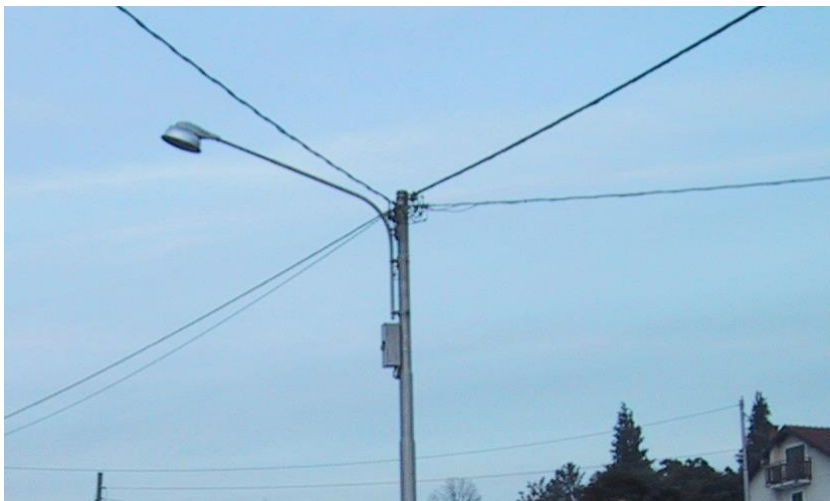
SP 31: giunzioni di cavi su palo in c.a.c.
