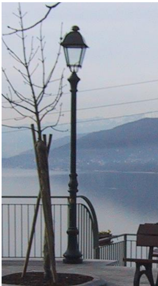
Belvedere di via Roma: apparecchi decorativi totalmente schermati installati su palo
