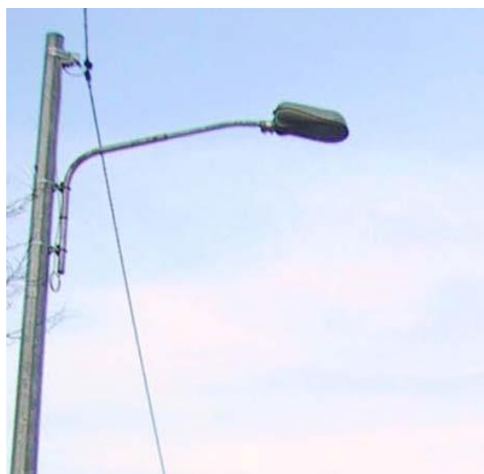
SP 69: armature stradali con vetro di chiusura piano a norma di L.R. 17/2000 e L.R.38/2004
