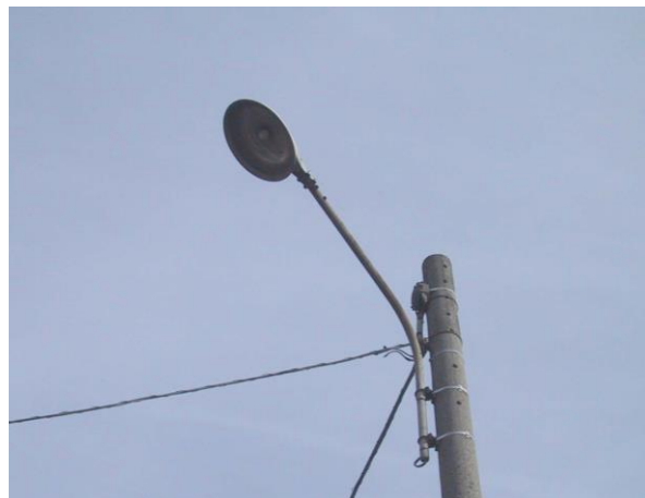
Via Del Cantone: armatura stradale aperta
