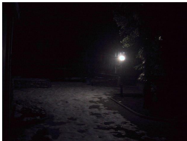
Area pubblica di Brezzo - percezione diurna e notturna: apparecchi decorativi tipo globo diffondente non conformi alla normativa vigente. E' evidente dalla percezione fotografica notturna la dispersione del flusso luminoso verso la volta celeste
