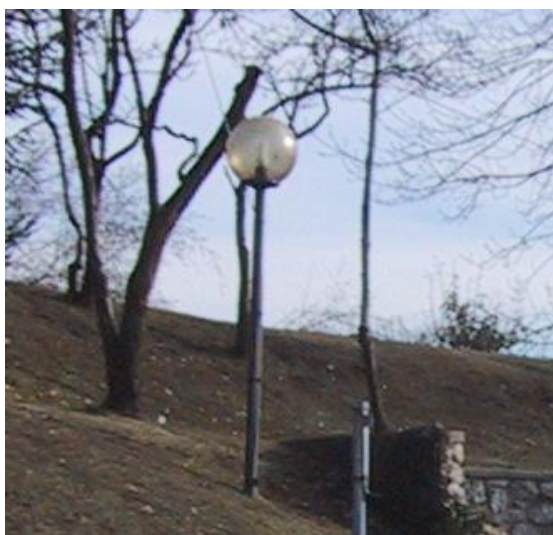
Parco di Via Monte Grappa: apparecchio decorativo tipo globo diffondente non conforme alla L.R.17/00 e alla L.R. 38/04
