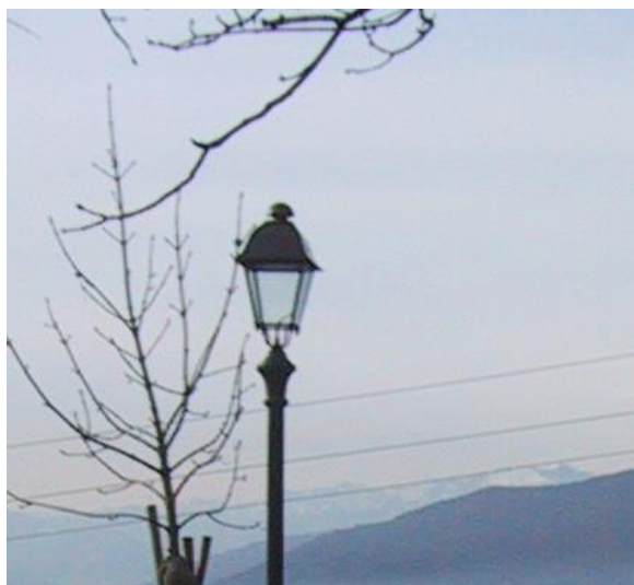
Belvedere di Via Roma: apparecchio decorativo totalmente schermato conforme alla normativa vigente.
