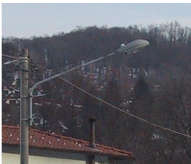
SP 43: armature stradali con vetro di chiusura piano a norma di L.R. 17/2000 e L.R.38/2004
