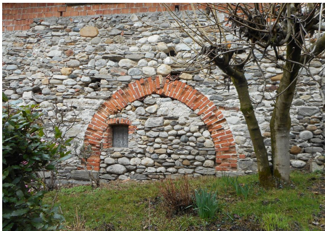
Dettaglio delle murature del muro di cinta: arco tamponato in laterizio del XV sec.
