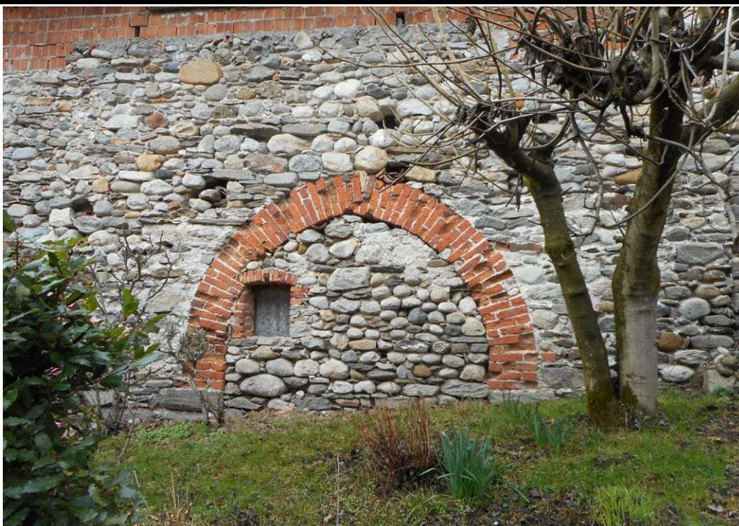
Dettaglio delle murature del muro di cinta in corrispondenza del secondo fabbricato interno al lotto (v. scheda VI.4): arco tamponato in laterizio del XV sec.
