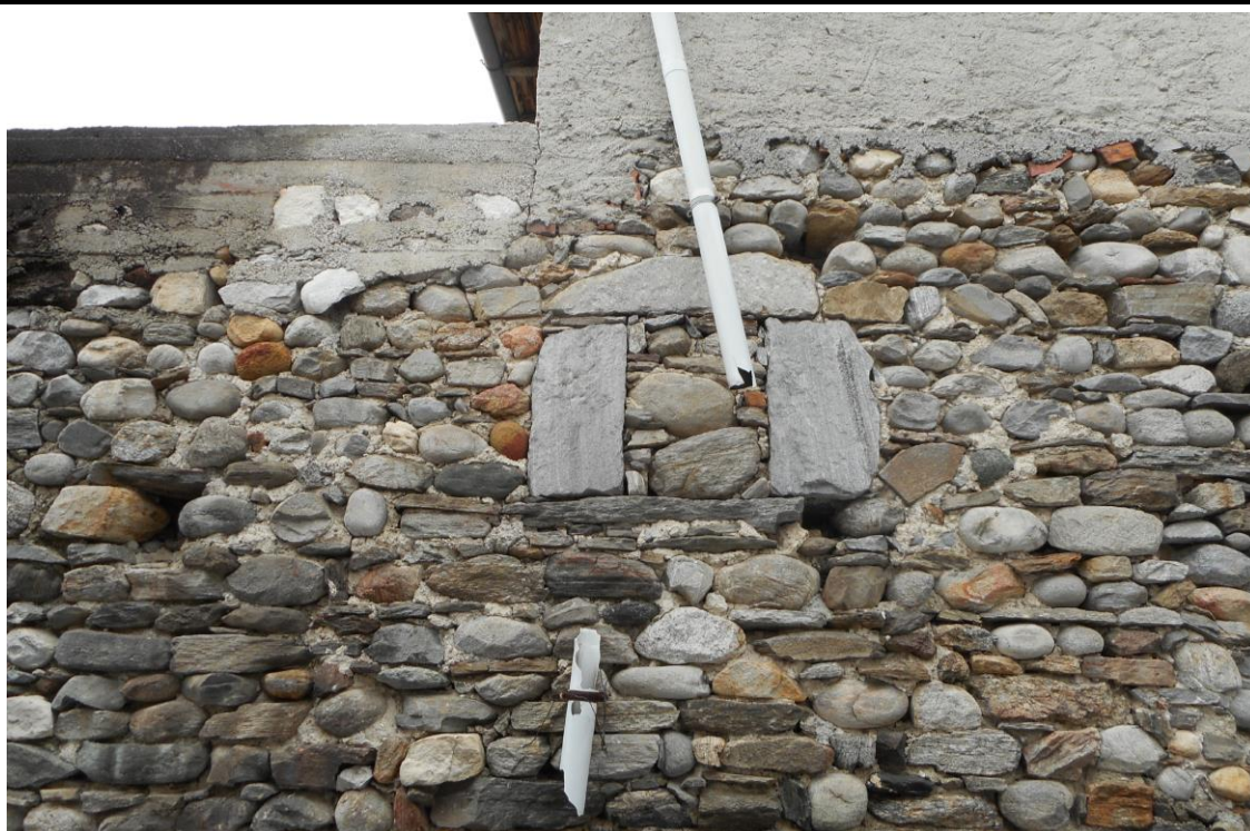
Dettaglio delle murature del muro di cinta in corrispondenza del secondo fabbricato interno al lotto (v. scheda VI.2): le murature sono medievali (XIII sec.?), come la finestra trilitica tamponata
