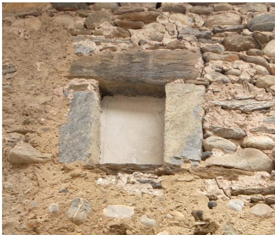
Finestrella trilitica (XIII sec.?) sulle murature del lotto lungo la via interna all'isolato
