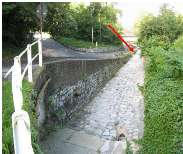
Fig. 3.15 – tratto terminale del Torrente Varesella; la freccia indica il ridottissimo confinamento dell'alveo in sponda sinistra; si osserva anche la riduzione della sezione per la presenza di una strada
